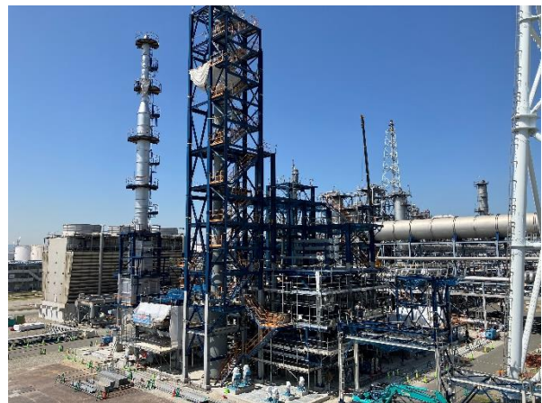
建設中のSAF製造装置（大阪府堺市）
