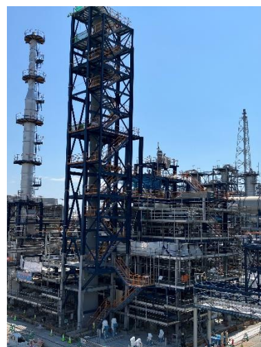
建設中の SAF 製造装置
