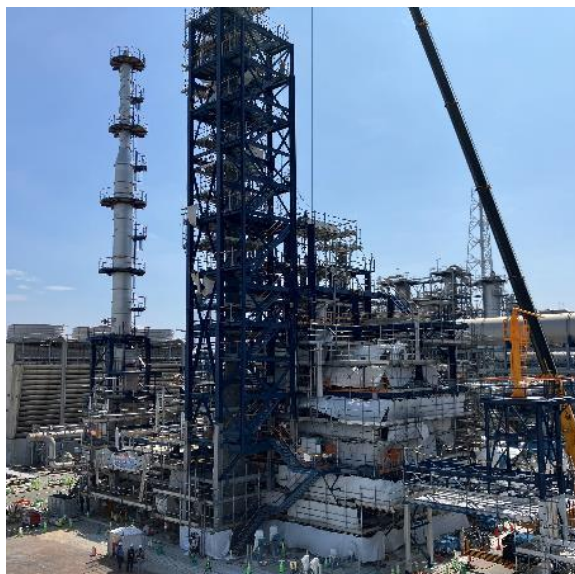
建設中の SAF 製造プラント
