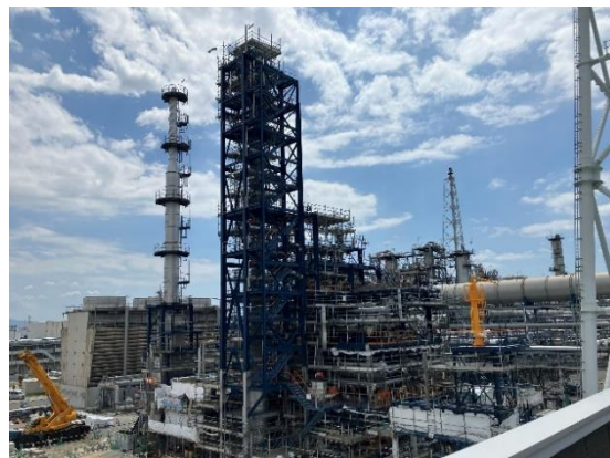
大阪府堺市で建設中の SAF 製造工場
