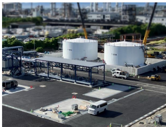
SAFの原料となる廃食用油受け入れ施設 (コスモ石油堺製油所構内)
