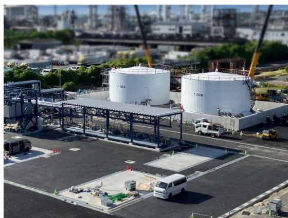
SAF の原料となる廃食用油受け入れ施設 (コスモ石油堺製油所構内)
