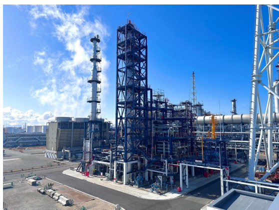
完工した SAF 製造装置
